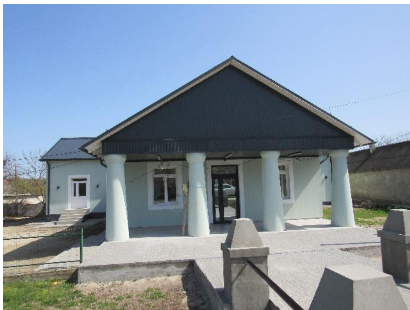
Figura 5. Casa de cultură din s Alexandrovca (deja este izolată termic)
